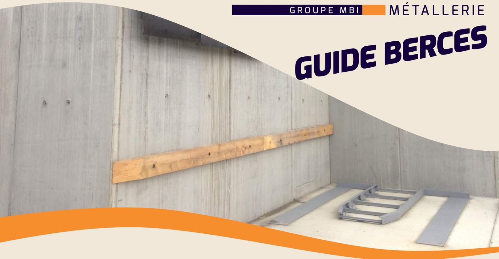
Permet à la benne d'être manipuler en bord de quai sans frottement ou choc avec le quai. C'est un système « universel » (toutes bennes, toutes marques de bennes amovibles) qui évite les détériorations prématurées des bennes comme des quais tout en positionnant la benne toujours à la même place.
